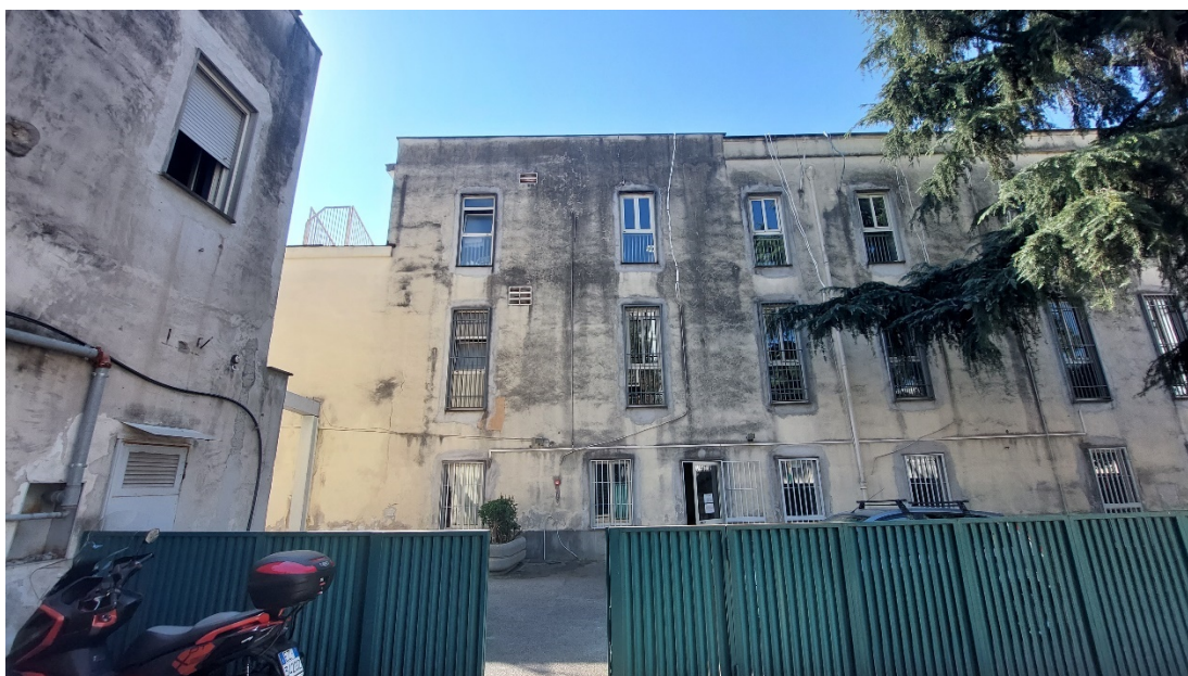
I prospetti privi di protezione e di cornice di coronamento
